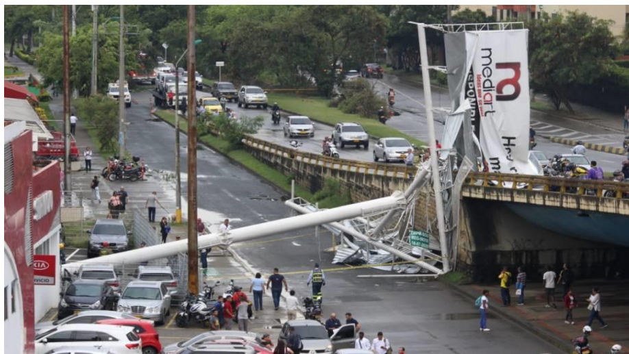
VISTA DEL EVENTO DE DESPLOME DE LA ESTRUCTURA - www.elpais.com.co
